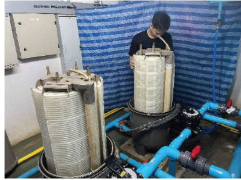
ล้างเครื่องกรองสระว่ายน้ำ ภาพที่ 2.2-28 เจ้าหน้าที่ดูแลสระว่ายน้ำ
