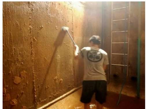
ภาพที่ 2.2-12 ทำความสะอาดถังน้ำใช้
