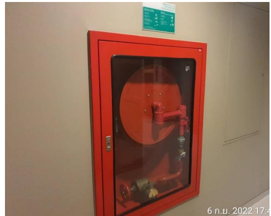
ตู้เก็บสายน้ำดับเพลิงพร้อมอุปกรณ์
