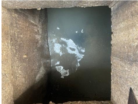
ภาพที่ 2.2-7 การตัดตะกอนจากบ่อดักไขมันและบ่อเกรอะ
