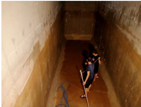
ภาพที่ 2.2-12 (ต่อ) ทำความสะอาดถึงน้ำใช้
