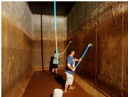
ภาพที่ 2.2-12 ทำความสะอาดถังน้ำใช้
