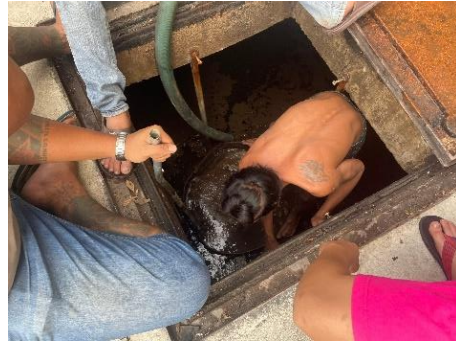
ภาพที่ 2.2-7 การตัดตะกอนจากบ่อดักไขมันและบ่อเกรอะ
