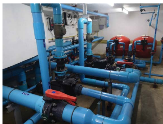
รูปที่ 13 ระบบฆ่าเชื้อโรคชนิด Salt Chlorination
