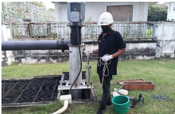
รูปที่ 2-19 การเก็บตัวอย่างน้ำจากระบบบำบัดน้ำเสีย
