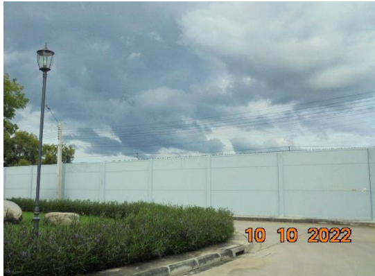
รูปที่ 2-3 รั้วรอบพื้นที่โครงการที่มีส่วนกันขโมย ความสูง 2.8 เมตร
