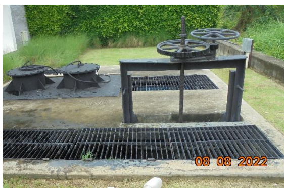
รูปที่ 2-4 ระบบบำบัดน้ำเสียขั้นต้นประจำบ้าน (บน) และระบบบำบัดน้ำเสียรวมส่วนกลาง พื้นที่ที่ 1 และถังดักละออง (ล่าง)
