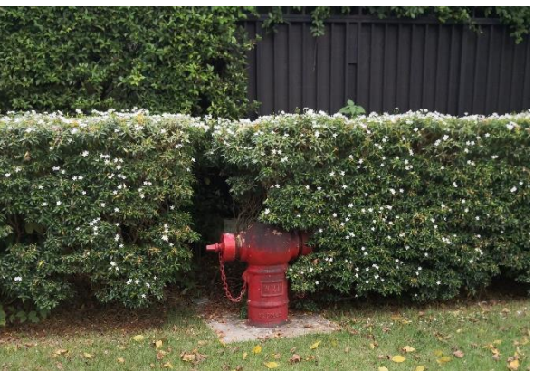
รูปที่ 2-15 หัวจ่ายน้ำดับเพลิงและอุปกรณ์ป้องกันอัคคีภัยเบื้องต้น
