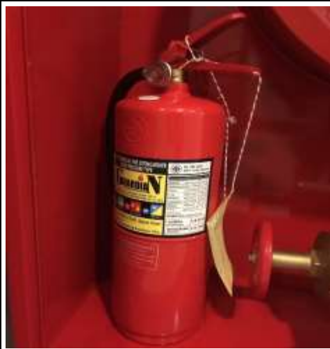
รูปที่ 2.4.8-7 เครื่องดับเพลิงแบบมือถือ
