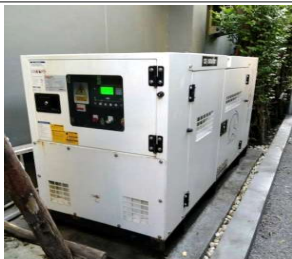
รูปที่ 2.4.6-2 เครื่องกำเนิดไฟฟ้าสำรอง
