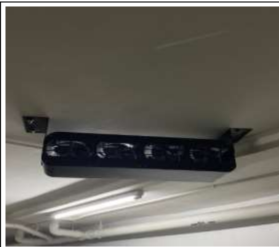
รูปที่ 2.4.7-1 พัดลมระบายอากาศ
