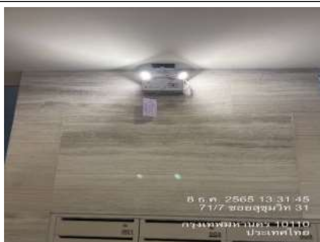
รูปที่ 2.4.8-9 ไฟส่องสว่างฉุกเฉิน
