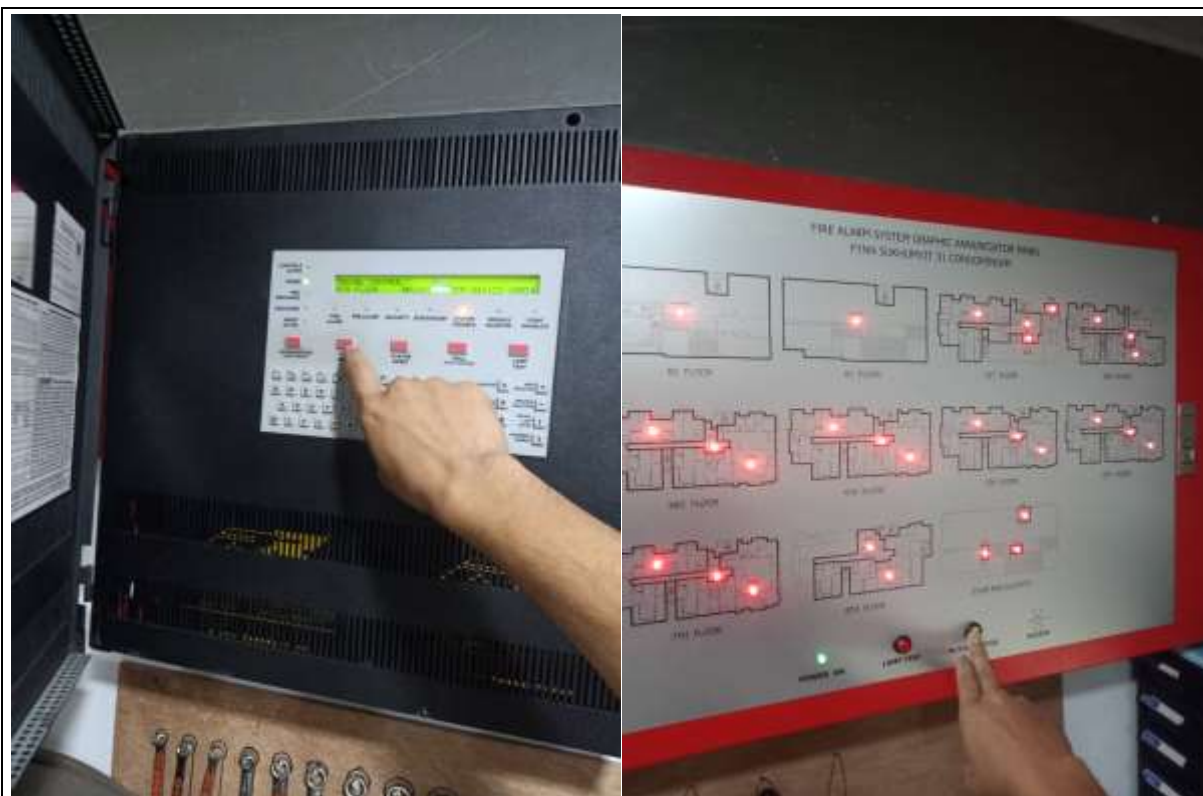
ภาคผนวกที่ 3-16 ตรวจสอบระบบเตือนภัยและป้องกัน อัคคีภัยให้ใช้ได้
