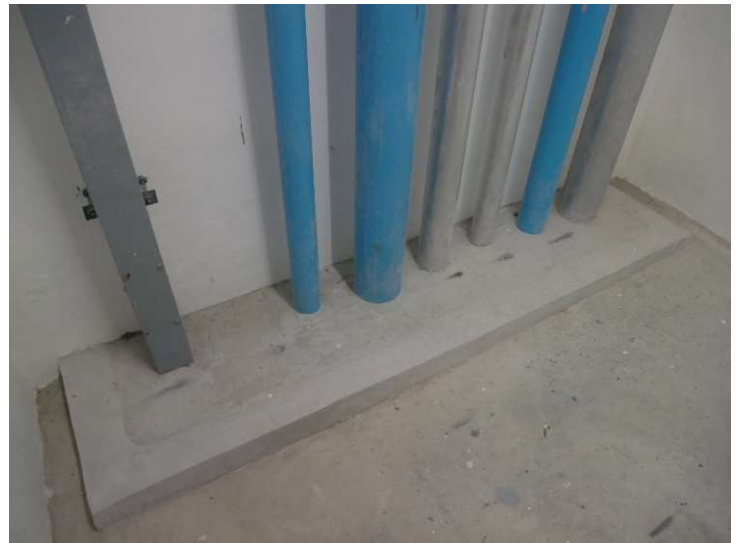
การปิดช่องเปิดระหว่างชั้น (ชาร์ปงานระบบ) ป้องกันการแพร่กระจายควันไฟ
