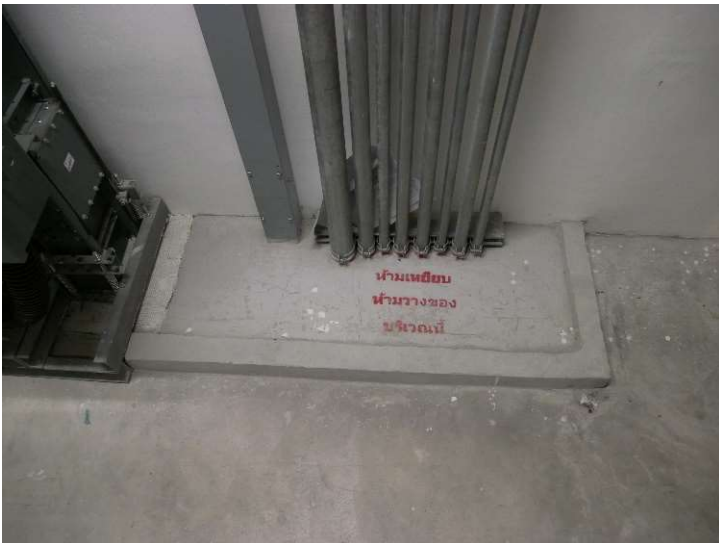
การปิดช่องเปิดระหว่างชั้น (ชาร์ปงานระบบ) ป้องกันการแพร่กระจายควันไฟ
