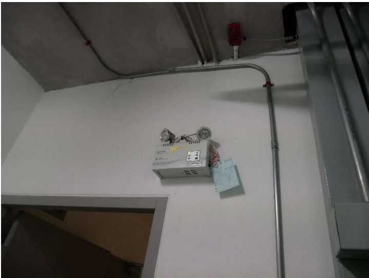
ตัวอย่างไฟส่องสว่างฉุกเฉิน
