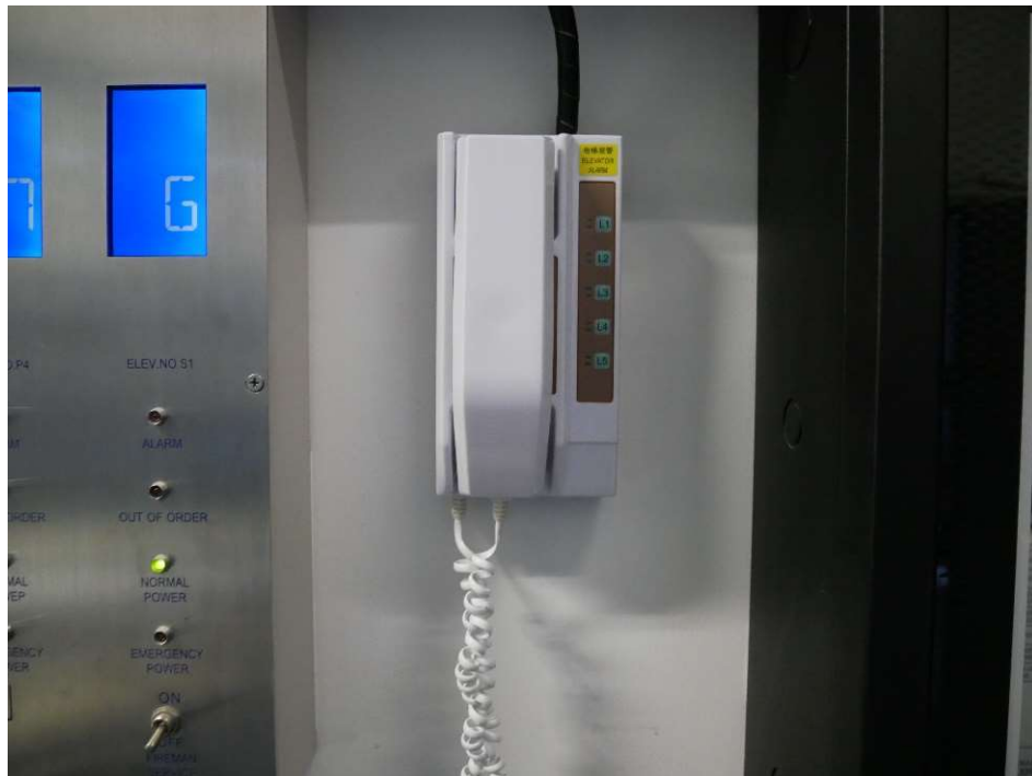
ภาพอุปกรณ์รับแจ้งเหตุฉุกเฉินของระบบลิฟต์
