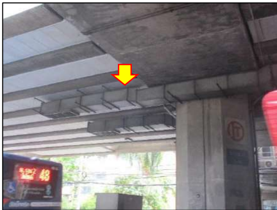
รูปที่ 2-21 ระบบระบายอากาศใต้สถานีบางจาก
