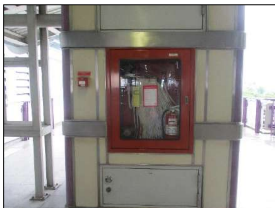
รูปที่ 2-17 การติดตั้งอุปกรณ์ดับเพลิง บริเวณสถานี S7-S8
