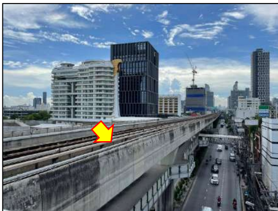
รูปที่ 2-22 กำแพงกันเสียงสูง 1.20 เมตร ตลอดสองข้างทางของรางรถไฟฟ้า บริเวณสถานี E10-E14
