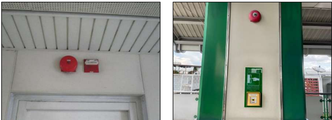
รูปที่ 2-39 การติดตั้งอุปกรณ์เตือนภัยกรณีเกิดเหตุฉุกเฉิน บริเวณสถานี E10-E14
