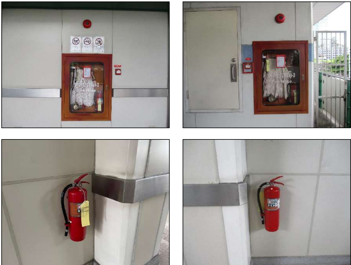
รูปที่ 2-38 การติดตั้งอุปกรณ์ดับเพลิง บริเวณสถานี E10-E14
