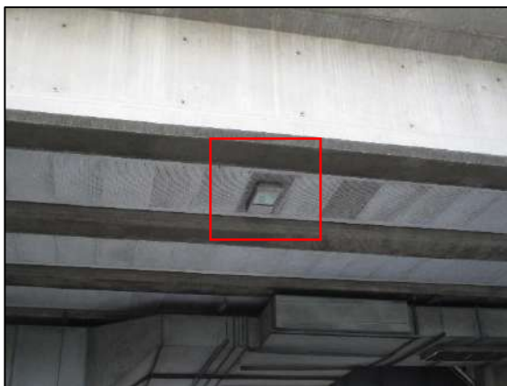
รูปที่ 2-28 การติดตั้งไฟส่องสว่างบริเวณใต้สถานีและด้านข้างริมทางเดินเท้า บริเวณสถานี E10-E14
