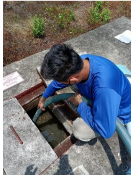
ตรวจเช็คบ่อบำบัดน้ำเสีย - สูบกากตะกอนส่วนเกิน
