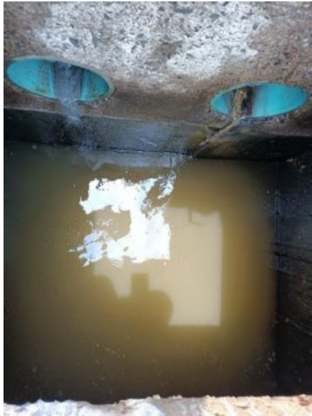
ตรวจเช็คบ่อบำบัดน้ำเสีย - สูบกากตะกอนส่วนเกิน
