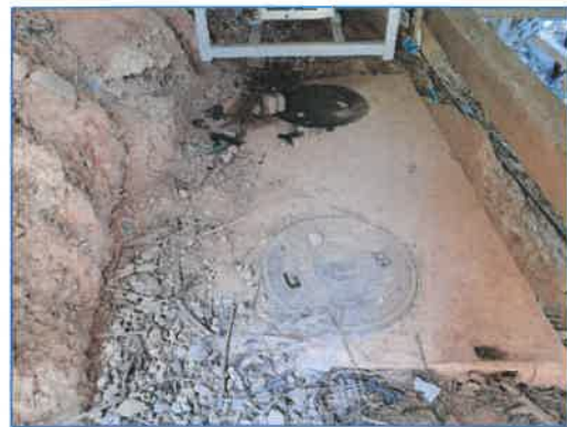
ภาพถ่ายที่ 2.2-3 ระบบบำบัดน้ำเสียสำเร็จรูปของโรงแรมสำหรับห้องพัก
