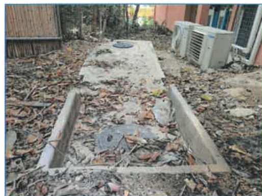
ภาพถ่ายที่ 2.2-4 ระบบบำบัดน้ำเสียสำเร็จรูปของโรงแรมสำหรับอาคารอื่นๆ
