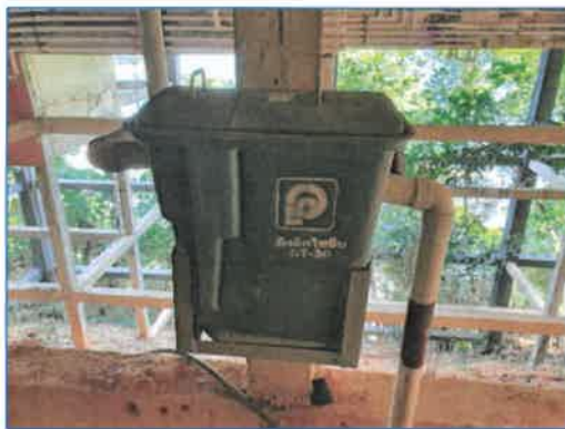
ภาพถ่ายที่ 2.2-3 ระบบบำบัดน้ำเสียสำเร็จรูปของโรงแรมสำหรับห้องพัก
