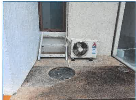
บ่อดักน้ำทิ้งก่อนเข้าระบบบำบัดน้ำเสียรวม
