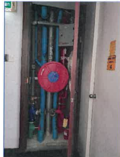
ภาพถ่ายที่ 2.2-8 ตู้ดับเพลิง (Fire Hose Cabinet)
