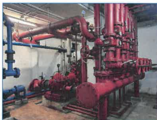
ระบบปั๊มน้ำสำรองดับเพลิง
