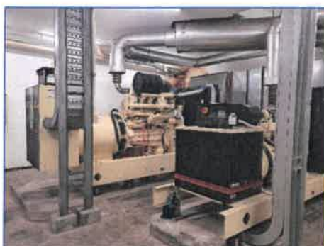
ภาพถ่ายที่ 2.2-13 เครื่องสำรองไฟฟ้า
