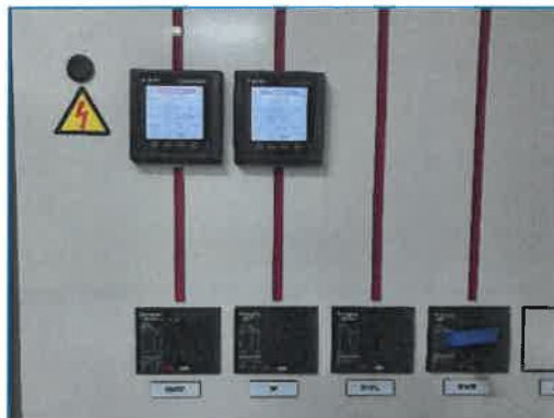
ภาพถ่ายที่ 2.2-10 ระบบมิเตอร์ไฟฟ้าของระบบบำบัดน้ำเสีย
