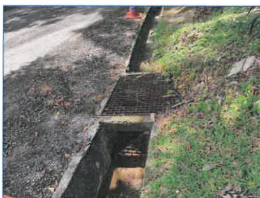
ภาพถ่ายที่ 2.2-4 ตะแกรงดักมูลฝอยบริเวณจุดระบายน้ำ
