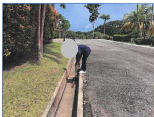
ภาพถ่ายที่ 2.2-5 การทำความสะอาดรางระบายน้ำ
