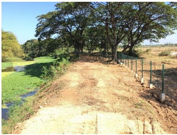
รูปที่ 3-1 คั่นดินบริเวณแนวเขตที่ดินใกล้กับน้ำแม่กวัง
