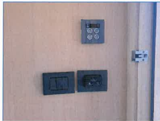
ภาพถ่ายที่ 2.2-19 ดิย์การ์ดห้องพักชนิดดิย์แท็กประหยัดไฟฟ้า
