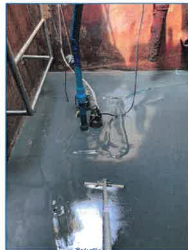
ภาพถ่ายที่ 2.2-9 การล้างทำความสะอาดถึงเก็บน้ำใช้
