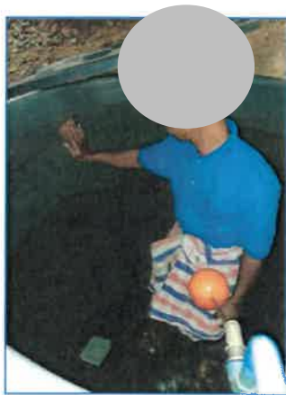
ภาพถ่ายที่ 2.2-25 การล้างทำความสะอาดถังน้ำใช้
