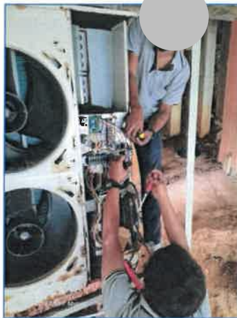
ภาพถ่ายที่ 2.2-21 การทำความสะอาดเครื่องปรับอากาศ
