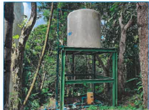
ถังเก็บน้ำเพื่อนำน้ำทิ้งไปรดน้ำต้นไม้
