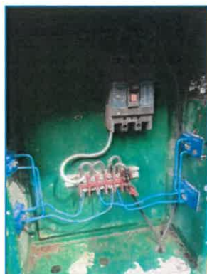
ภาพถ่ายที่ 2.1-16 การติดตั้งอุปกรณ์และการจ่ายไฟฟ้าถูกต้อง
