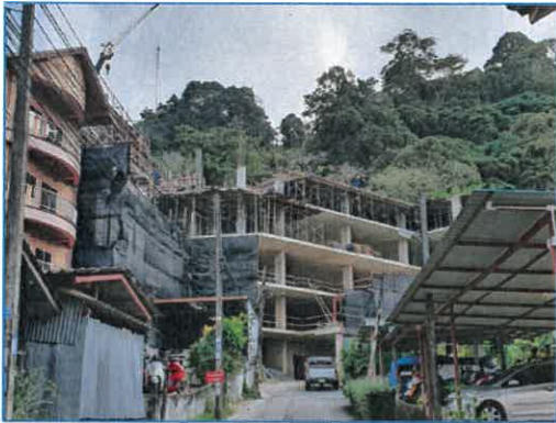
ภาพถ่ายที่ 2.1-3 ตาข่ายกันรอบตัวอาคารและตลอดความสูงของอาคารที่กำลังก่อสร้าง (ต่อ)
