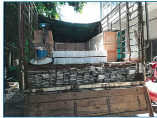
ภาพถ่ายที่ 2.1-8 ผ้าใบปิดคลุมกระบะรถที่ขนส่งวัสดุก่อสร้าง
