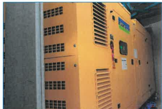
ภาพถ่ายที่ 2.2-23 เครื่องกำเนิดไฟฟ้าสำรองของ โรงแรม
