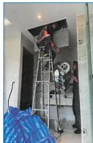
ภาพถ่ายที่ 2.2-31 การทำความสะอาดระบบปรับอากาศและระบบระบายอากาศ
