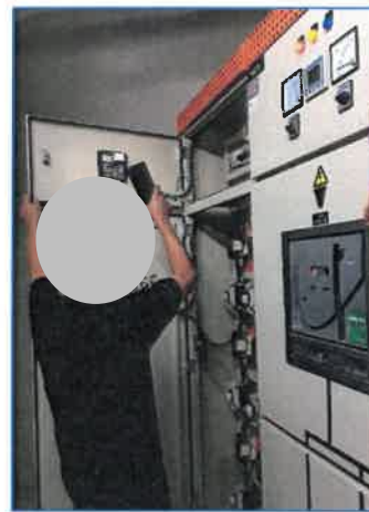
ภาพถ่ายที่ 2.2-25 การตรวจสอบระบบควบคุมไฟฟ้า MDB
