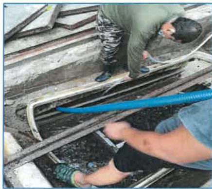
ภาพถ่ายที่ 2.2-17 การดูดกากตะกอนจากระบบบำบัดน้ำเสีย
