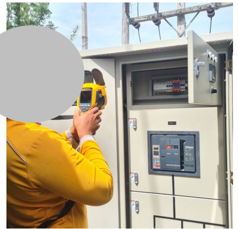
บริษัทภายนอกเข้ามาตรวจเช็คตู้ควบคุมระบบไฟฟ้าแรงสูงประจำปี Maintaining main distribution board in project by outsource.
