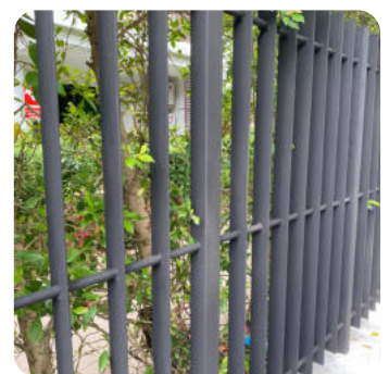
ช่างนิติได้ทำความสะอาดและทาสีกันตะไคร่น้ำบนกำแพงโครงการ Cleaning and Paint moss repellent on project wall.
