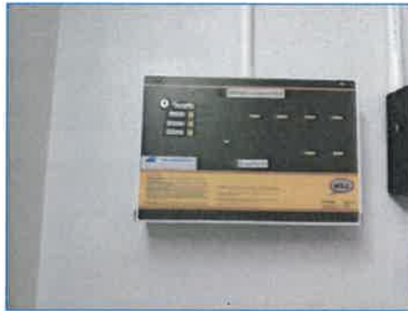
ภาพถ่ายที่ 2.2-18 ตู้ควบคุมระบบแจ้งเตือนป้องกันอัคคีภัย
