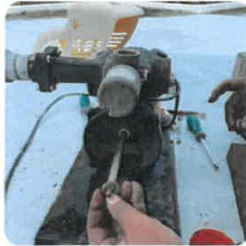
ภาพถ่ายที่ 2.2-7 การเปลี่ยนอุปกรณ์ปั๊มน้ำขาดฟ้าที่ชำรุด
