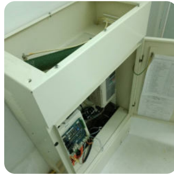
เช็คพัดลมตู้ควบคุมลิฟท์ Checking ventilation fan.
