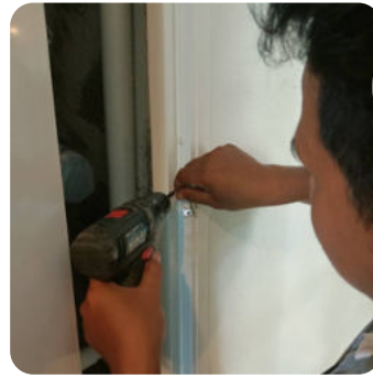
ช่างนิติได้ซ่อมบำรุงตัวล็อคตู้มิเตอร์น้ำ Repairing the lock of the water meter cabinet.
