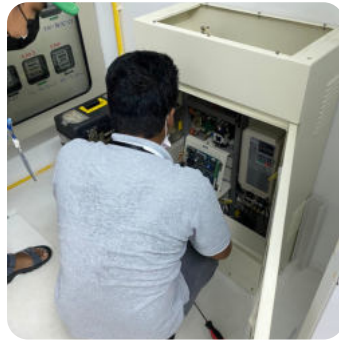
เช็คพัดลมตู้ควบคุมลิฟท์ Checking ventilation fan.
