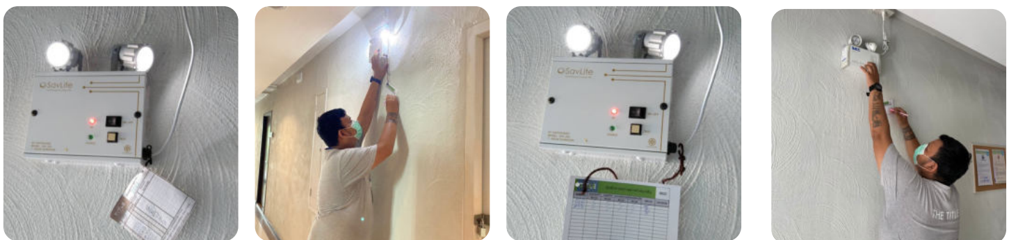
ตรวจเช็คไฟฉุกเฉินอาคาร A-G Checking emergency light building A-G
