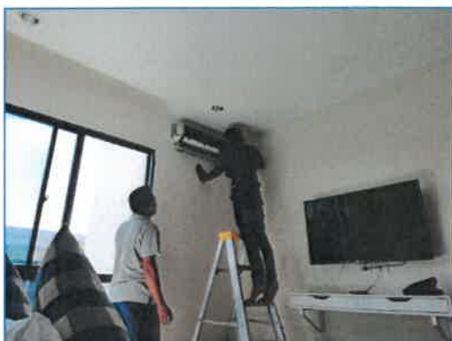
ภาพถ่ายที่ 2.2-16 การทำความสะอาด เครื่องปรับอากาศ
