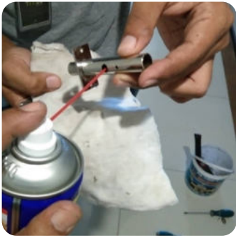
ช่างนิติได้ซ่อมบำรุงตัวล็อคตู้มิเตอร์น้ำ Repairing the lock of the water meter cabinet.
