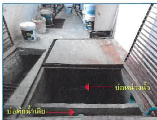
ภาพถ่ายที่ 2.2-13 บ่อท่ว่งน้ำและบ่อพักน้ำเสีย พร้อมตะแกรงดักมูลฝอย
