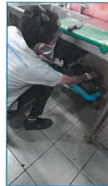
ภาพถ่ายที่ 2.2-16(3) การตัดกากไขมัน
