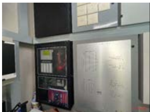
รูปที่ 2-33 แผงควบคุม (Fire Alarm Control Panel: FCP)
