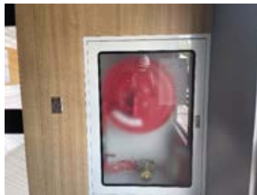
รูปที่ 2-32 ตู้เก็บสายฉีดน้ำดับเพลิงพร้อมอุปกรณ์ (Fire Hose Cabinet : FHC)
