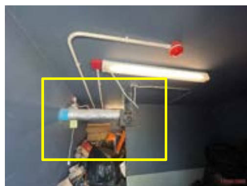
รูปที่ 2-25 ติดตั้งพัดลมระบายอากาศที่ห้องพักมูลฝอย
