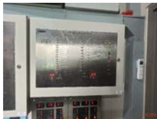
รูปที่ 2-33 แผงควบคุม (Fire Alarm Control Panel: FCP)
