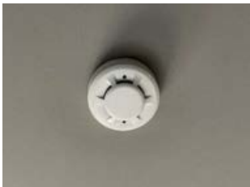
รูปที่ 2-36 ติดตั้งเครื่องตรวจจับควัน
