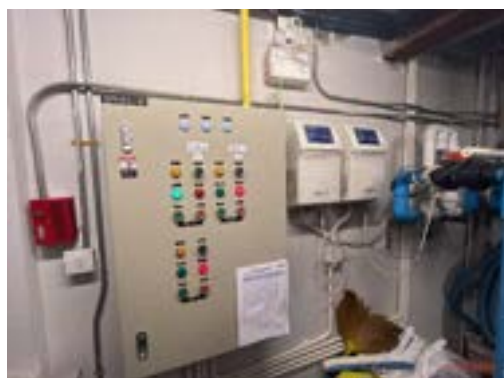
รูปที่ 2-15 ระบบเกลือ (Salt Chlorinator) ในการฆ่าเชื้อโรคในสระว่ายน้ำ
