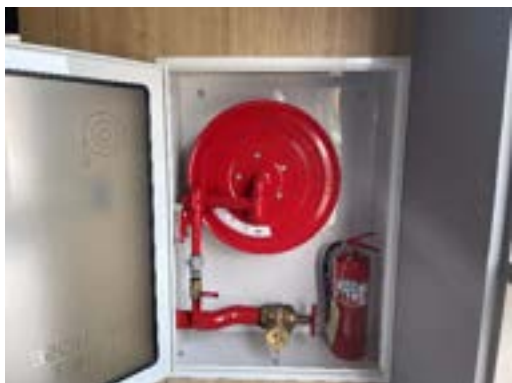
รูปที่ 2-32 ตู้เก็บสายฉีดน้ำดับเพลิงพร้อมอุปกรณ์ (Fire Hose Cabinet : FHC)
