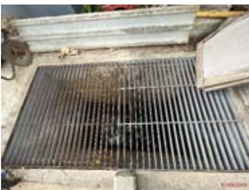
รูปที่ 2-47 ติดตั้งบ่อหน่วงน้ำพร้อมตะแกรงครอบ
