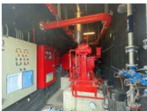
รูปที่ 2-30 ติดตั้งเครื่องสูบน้ำดับเพลิง
