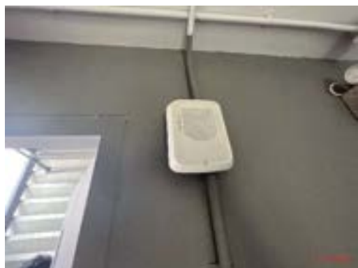
รูปที่ 2-38 ติดตั้งลำโพงสัญญาณเตือนภัย
