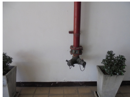
ภาพที่ 4-19 ป้อนน้ำดับเพลิง ตู้ FHC และหัวรับน้ำดับเพลิงภายนอก
