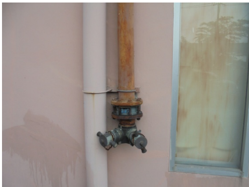
ภาพที่ 4-19 ป้อนน้ำดับเพลิง ตู้ FHC และหัวรับน้ำดับเพลิงภายนอก
