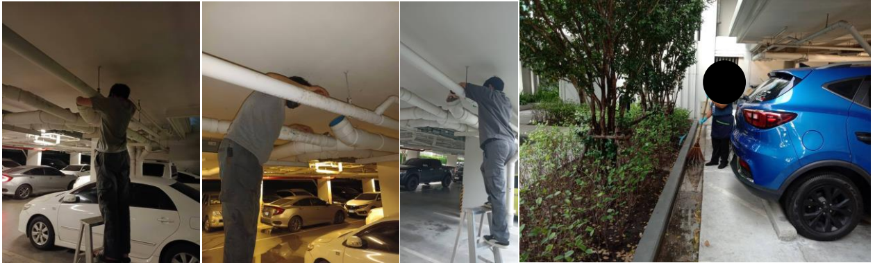
รูปที่ 2-33 ตรวจสอบและทำความสะอาดท่อระบายน้ำ
