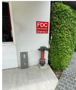
หัวรับน้ำดับเพลิงอาคาร A และอาคาร B
