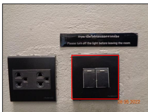
รูปที่ 2-54 แยกสวิตช์ควบคุมไฟฟ้าแสงสว่าง และเครื่องปรับระดับแสงสว่าง (Dimmer)
