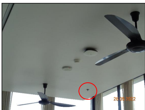
รูปที่ 2-65 ระบบหัวจ่ายน้ำดับเพลิงอัตโนมัติ (Sprinkler System) ทุกชั้นอาคาร (2)
