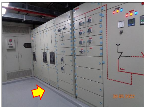
รูปที่ 2-49 มาตรการป้องกันและแก้ไขผลกระทบที่อาจเกิดขึ้นจากการติดตั้งหม้อแปลง เช่น เครื่องมือตรวจจับควัน ป้ายแสดงข้อความ “อันตรายไฟฟ้าแรงสูง” (1)
