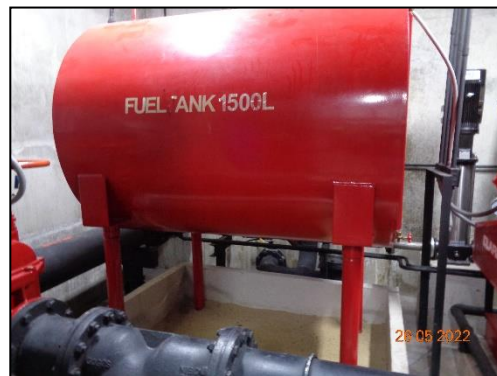
รูปที่ 2-62 เครื่องสูบน้ำดับเพลิง (Fire Pump) ชนิดเครื่องยนต์ดีเซล จำนวน 1 เครื่อง ทำงานร่วมกับ เครื่องสูบน้ำรักษาความดันในระบบท่อให้คงที่ (Jockey Pump) จำนวน 1 เครื่อง (2)
