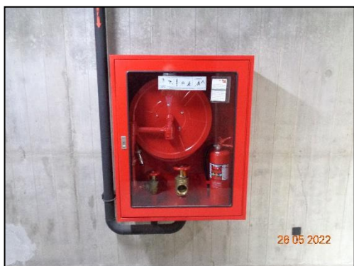
รูปที่ 2-69 ตู้เก็บสายฉีดน้ำดับเพลิงพร้อมอุปกรณ์ (Fire House Cabinet: FHC) ติดตั้งถังดับเพลิงคาร์บอนไดออกไซด์แบบมือถือ ไว้บริเวณห้องเครื่องไฟฟ้า
