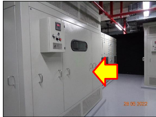
รูปที่ 2-44 หม้อแปลงชนิด Dry Type ขนาด 1,250 KVA จำนวน 2 ชุด สำหรับแปลงไฟฟ้าแรงสูง เพื่อจ่ายไปยัง Load ต่าง ๆ (1)
