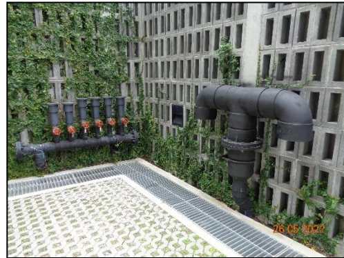
รูปที่ 2-14 ระบบบำบัด Aerosol ที่เกิดจากระบบบำบัดน้ำเสีย เข้าท่อระบายอากาศ (ท่อ Vent)
