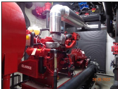
รูปที่ 2-61 เครื่องสูบน้ำดับเพลิง (Fire Pump) ชนิดเครื่องยนต์ดีเซล จำนวน 1 เครื่อง ทำงานร่วมกับ เครื่องสูบน้ำรักษาความดันในระบบท่อให้คงที่ (Jockey Pump) จำนวน 1 เครื่อง (1)
