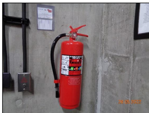
รูปที่ 2-70 ถังดับเพลิงเคมี (ABC Dry Chemical) แบบมือถือ บริเวณห้องเครื่องสูบน้ำดับเพลิงของอาคาร
