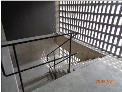
รูปที่ 2-79 บันไดหนีไฟทางอากาศจากพื้นที่ชั้นดาดฟ้า
