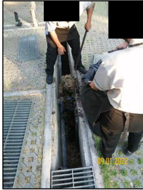
รูปที่ 2-91 ขุดลอกรางระบายน้ำ (1)
