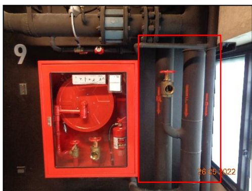
รูปที่ 2-63 ระบบท่อยืน (Stand Pipe)
