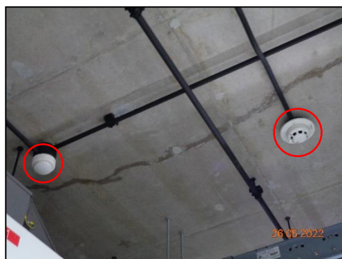
รูปที่ 2-52 มาตรการป้องกันและแก้ไขผลกระทบที่อาจเกิดขึ้นจากการติดตั้งหม้อแปลง เช่น เครื่องมือตรวจจับควัน ป้ายแสดงข้อความ “อันตรายไฟฟ้าแรงสูง” (4)
