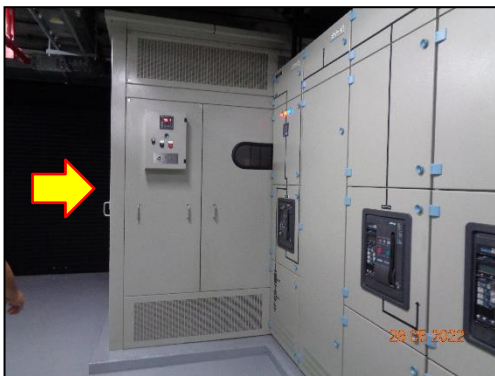
รูปที่ 2-45 หม้อแปลงชนิด Dry Type ขนาด 1,250 KVA จำนวน 2 ชุด สำหรับแปลงไฟฟ้าแรงสูง เพื่อจ่ายไปยัง Load ต่าง ๆ (2)
