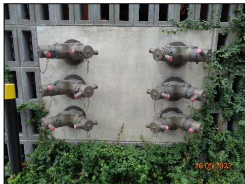
รูปที่ 2-68 หัวรับน้ำดับเพลิงภายนอกอาคาร (Fire Department Connector: FDC) พร้อม Check Valve
