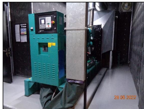
รูปที่ 2-46 เครื่องกำเนิดไฟฟ้า ขนาด 315 KVA จำนวน 1 ชุด สามารถสำรองไฟได้นาน 8 ชั่วโมง ในกรณีระบบไฟฟ้าขัดข้อง (1)
