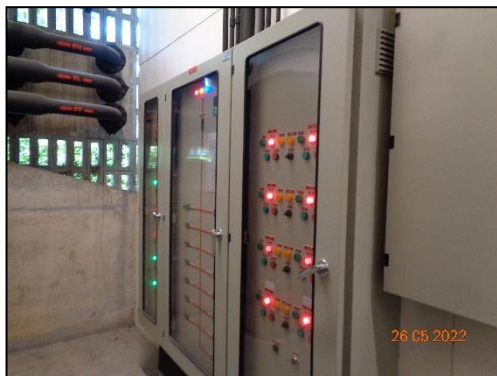
รูปที่ 2-15 ระบบมิเตอร์ไฟฟ้าสำหรับระบบบำบัดน้ำเสีย โดยเฉพาะ แยกจากระบบไฟฟ้าอื่น ๆ
