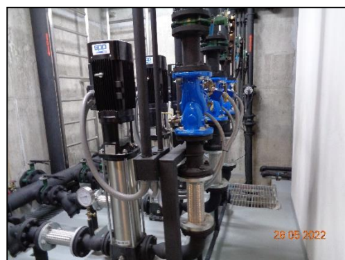
รูปที่ 2-18 ระบบสูบน้ำในอาคาร ซึ่งทำหน้าที่สูบน้ำโดยไม่ได้ดึงน้ำใช้มาจากท่อประปาโดยตรง และควบคุมการจ่ายน้ำด้วยระบบตั้งเวลา
