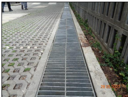
รูปที่ 2-93 ตะแกรงครอบตามรูท่อระบายน้ำ
