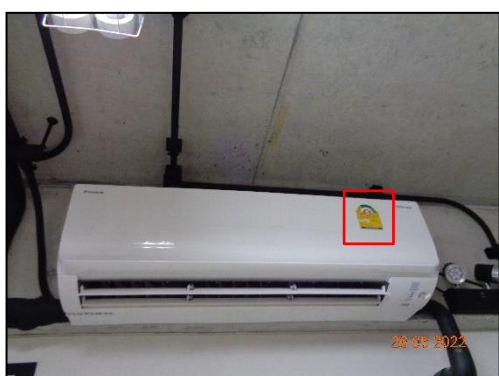
รูปที่ 2-53 ระบบปรับอากาศที่ติดตั้งภายในอาคาร ต้องมีค่าสัมประสิทธิ์สมรรถนะขั้นต่ำ ค่าประสิทธิภาพการให้ความเย็น และค่าพลังงานไฟฟ้าต่อตันความเย็นเป็นไปตามที่รัฐมนตรีประกาศกำหนด (ฉลากเบอร์ 5)
