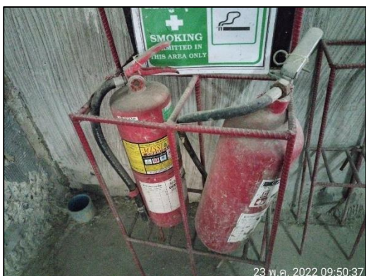
ภาพที่ 32 ถังดับเพลิงและป้ายแนะนำการใช้งาน (ต่อ)
