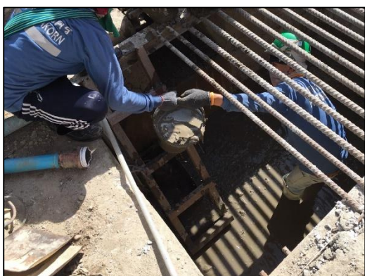
ภาพที่ 29 ขุดลอกตะกอนดินในบ่อพักน้ำ
