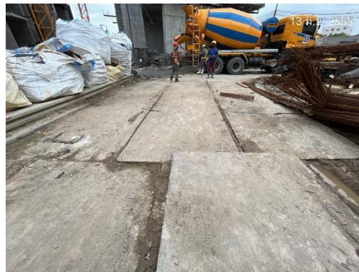
ภาพที่ 17 แผ่นเหล็กหนาปูบริเวณพื้นที่โครงการ
