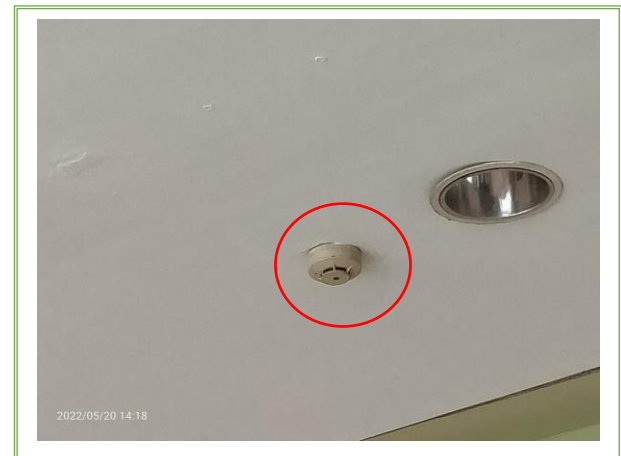
รูปที่ 3-25 Heat Detector
