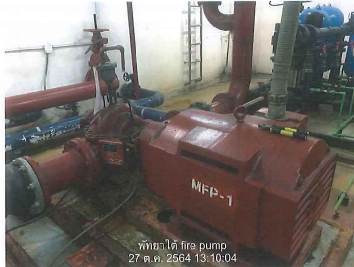
รูปที่ 2.1 ตรวจสอบสภาพทั่วไปของ Fire pump มีสภาพปกติ และทดสอบ start สามารถใช้งานได้
