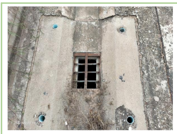
รูปที่ 3-4 ช่องระบายน้ำและตะแกรงดักขยะ
