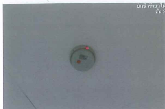
รูปที่ 1.5 Heat detector
