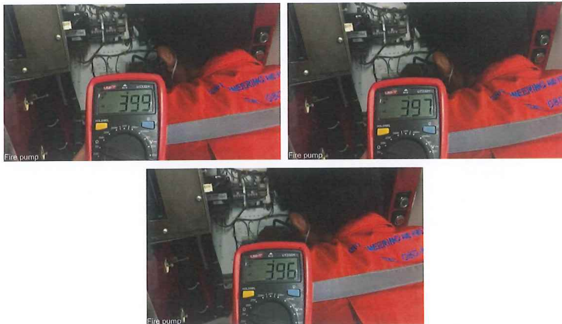
รูปที่ 2.2 ตรวจสอบค่ากระแสไฟฟ้าตู้ควบคุมเครื่องสูบน้ำ ขณะเครื่องสูบน้ำทำงาน
