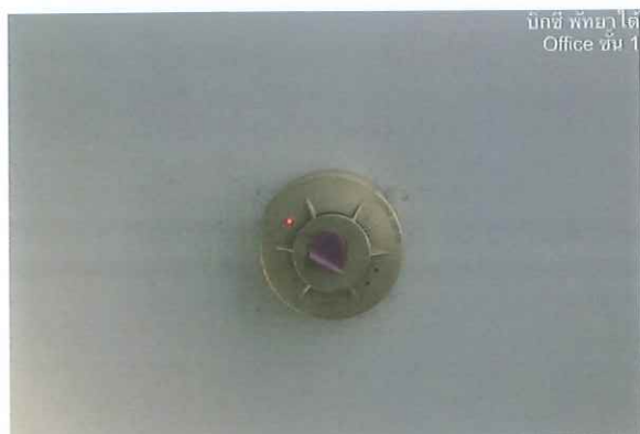
รูปที่ 1.4 Smoke detector
