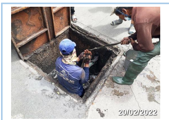
รูปที่ 3-14 การลอกท่อระบายน้ำของโครงการ
