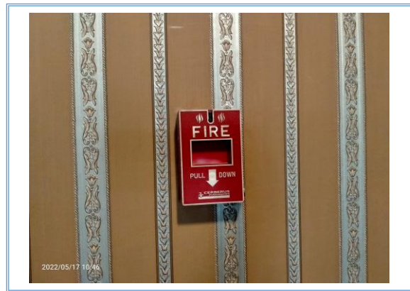
รูปที่ 3-58 สวิตช์แจ้งสัญญาณเพลิงไหม้อาคาร
