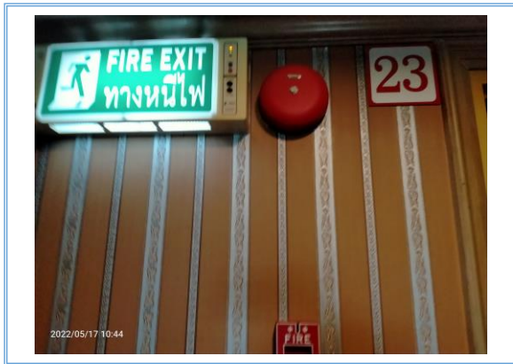
รูปที่ 3-57 อุปกรณ์ส่งเสียงสัญญาณเตือนภัย
