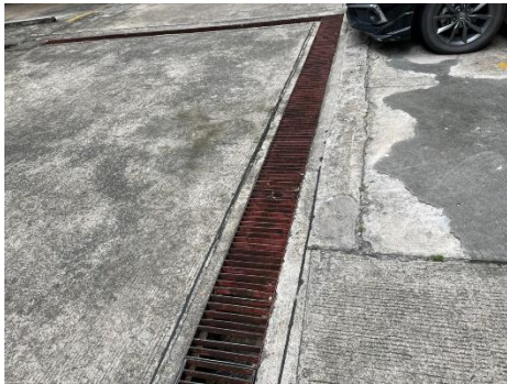
ภาพที่ 2-26 ตะแกรงดักขยะมูลฝอย
