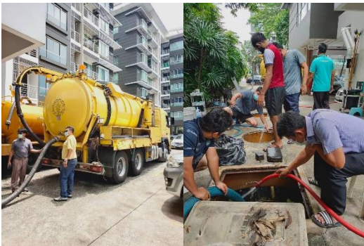
ภาพที่ 2-28 การสูบลากตะกอน
