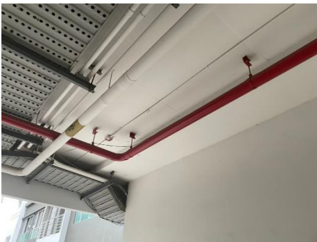
ภาพที่ 2-39(ต่อ) ระบบป้องกันอัคคีภัย และระบบแจ้งเหตุดับเพลิงไหม้
