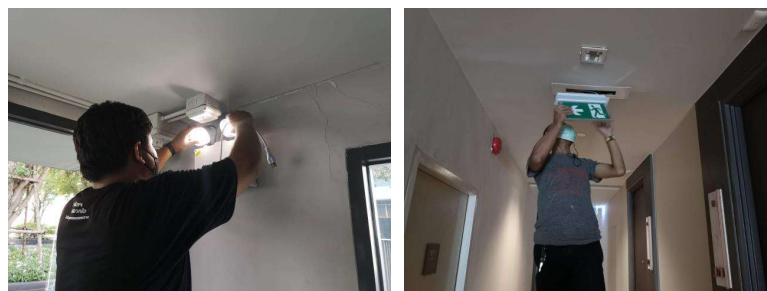
ช่างอาคารติดตั้ง Emergency Light และ ป้าย Fire Exit แทนที่ชำรุด
