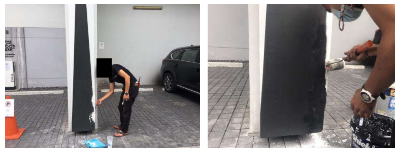
ช่างอาคารทาสีทับแทนที่หลอดร้อนบริเวณที่จอดรถสำหรับ EV Charger
