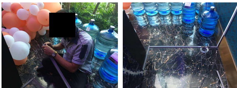
ช่างอาคารเปลี่ยนรางสายกล้อง cctv เคาน์เตอร์ล๊อบบี้
