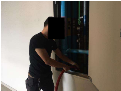
ช่างอาคารเปิดฝาดินน้ำล้างท่อน้ำเสีย และท้อ kw ไล่เศษขยะเศษกระดาษที่ขูไปอุดตันในท่อน้ำ
