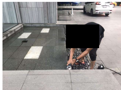
ช่างอาคารเจียขอบบ่อพลเติมเต็มเพื่อให้ น้ำไหลเวียนสะดวก
