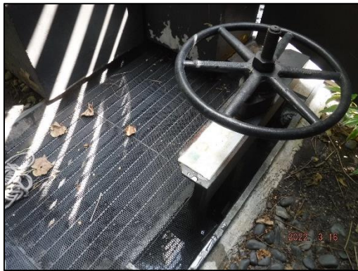
บ่อกักน้ำสุดท้ายของระบบระบายน้ำของโครงการก่อนระบายลงสู่ระบบระบายน้ำบริเวณด้านหน้าโครงการ วันที่ 16 มีนาคม พ.ศ. 2565
