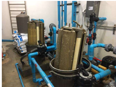
ช่างอาคารล้างทำความสะอาดไส้กรองสรว่ายน้ำตามแผนงานประจำสัปดาห์
