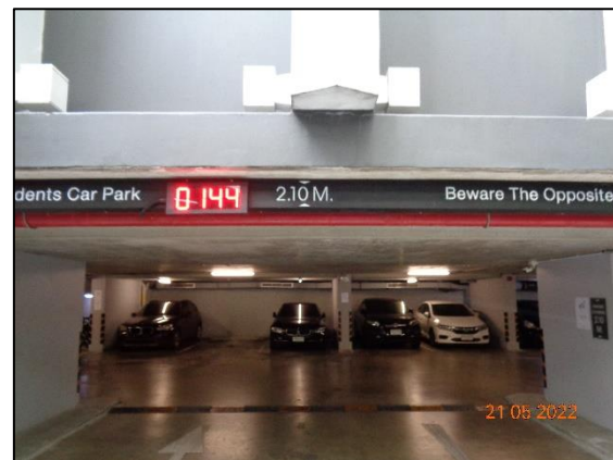
รูปที่ 2-45 ระบบสัญญาณไฟแจ้งจำนวนที่จอดรถ
