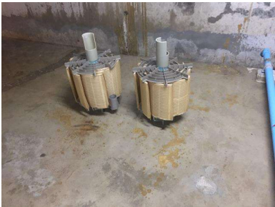
ช่างอาคารล้างทำความสะอาดไส้กรองสรว่ายน้ำตามแผนงานประจำสัปดาห์
