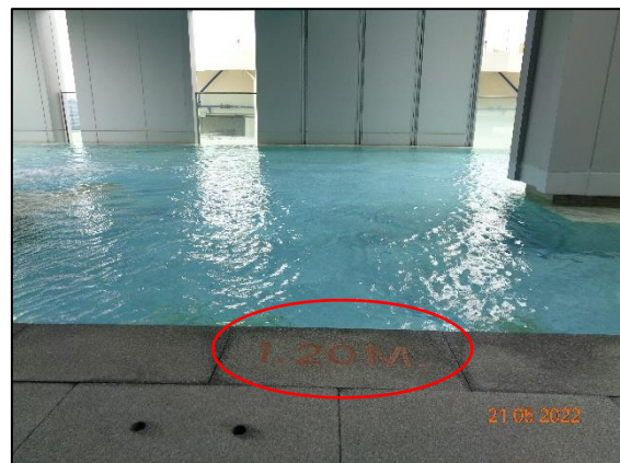
รูปที่ 2-56 รางระบายน้ำล้นสระว่ายน้ำ
