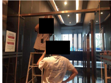
ช่างอาคารตรวจสอบและแก้ไขประตูทางเข้าโถงลิฟต์ ชั้น 1
