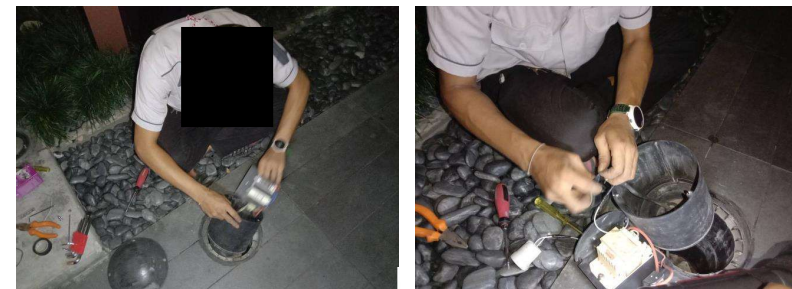
ช่างอาคารแก้ไขสายไฟและเปลี่ยนหลอดไฟบริเวณทางเดินแทนที่ชำรุด
