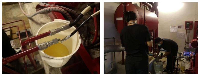
ช่างอาคารเปลี่ยนถ่านน้ำมัน ระบบ Fire Pump Low Zone
