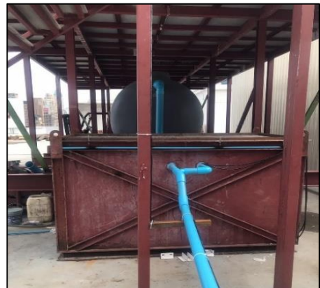
รูปที่ 2-19 ระบบบำบัดน้ำเสียของโครงการ
