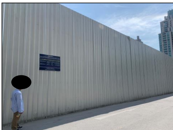
รูปที่ 2-12 รั้ว Metal Sheet
