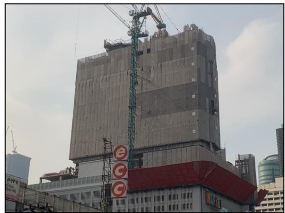
รูปที่ 2-3 ผ้าใบก่อสร้าง (Mesh Sheet)
