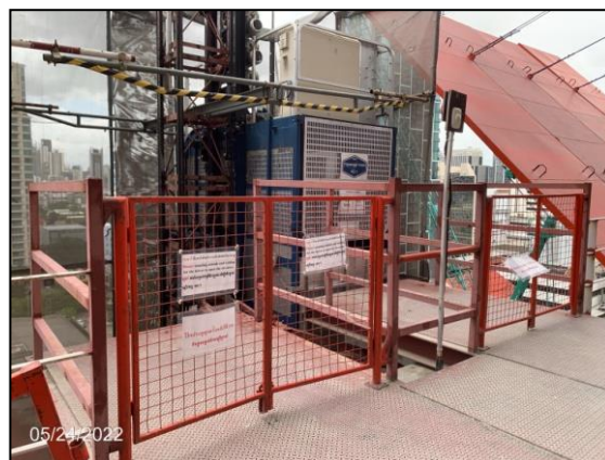
รูปที่ 2-46 ลิฟต์ขนส่งวัสดุ/อุปกรณ์ก่อสร้าง
