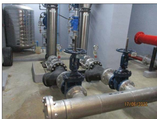
รูปที่ 9 ถังสำรองน้ำใช้ ฝาทรง วาล์วเปิดน้ำประปา สภาพน้ำในถัง และปั๊มสูบน้ำดับเพลิง
