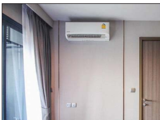
รูปที่ 22 เครื่องปรับอากาศภายในอาคารไม่ใช่สารCFC
