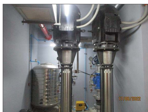
รูปที่ 9 ถังสำรองน้ำใช้ ฝาทรง วาล์วเปิดน้ำประปา สภาพน้ำในถัง และปั๊มสูบน้ำดับเพลิง
