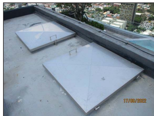
รูปที่ 11 ฝาบ่อเก็บน้ำใต้ดิน ปิดมิดชิด และยกสูงจากพื้น
