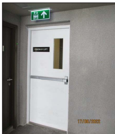
รูปที่ 45 ประตูหนีไฟของอาคารสามารถเปิดย้อนกลับในทิศทางเดิมได้
