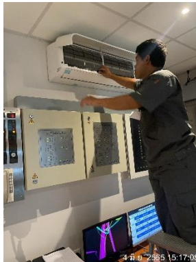
รูปที่ 3-23 ล้างเครื่องปรับอากาศและล้างฟิลเตอร์พื้นที่ส่วนกลาง
