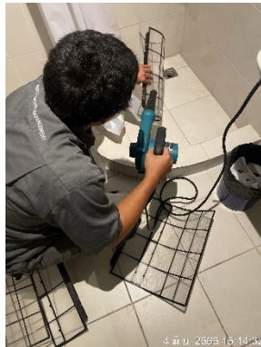
รูปที่ 3-23 ล้างเครื่องปรับอากาศและล้างฟิลเตอร์พื้นที่ส่วนกลาง
