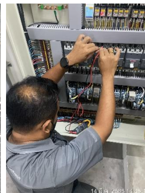
รูปที่ 3-32 ตรวจสอบตู้ควบคุมของระบบบำบัดน้ำเสีย
