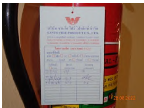
ภาพที่ 2.2-29 การตรวจสอบถังดับเพลิงแบบมือถือ
