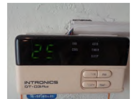
ภาพที่ 2.2-30 การตั้งค่าอุณหภูมิเครื่องปรับอากาศ
