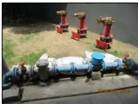
รูปที่ 2-28 การเชื่อมต่อท่อประปาของโครงการกับท่อประธานริมถนนสุขุมวิท
