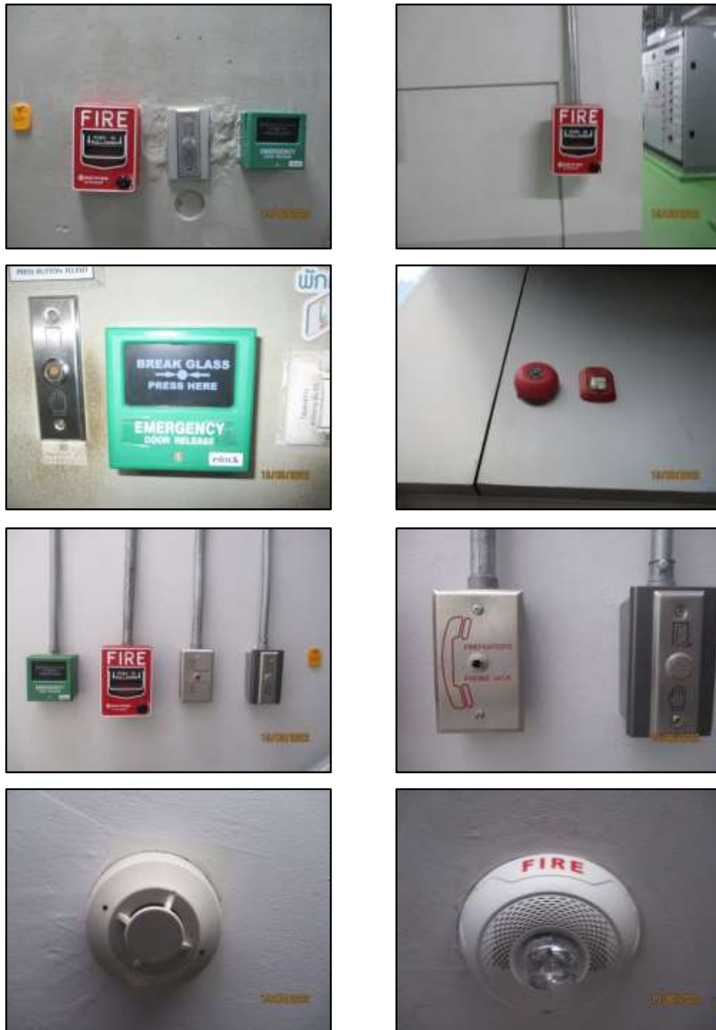
รูปที่ 2-55 ระบบสัญญาณแจ้งเหตุเพลิงไหม้ ของโครงการ
