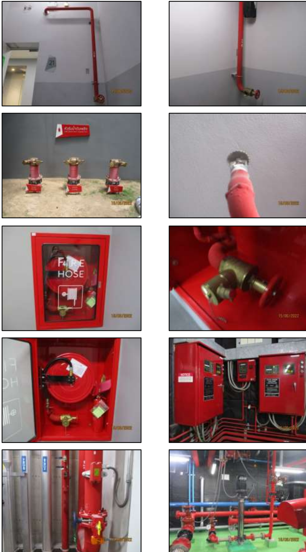
รูปที่ 2-53 ระบบน้ำดับเพลิงของโครงการ
