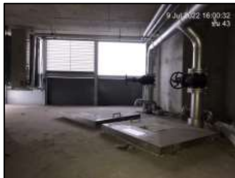
รูปที่ 2-30 ถังเก็บน้ำชั้นดาดฟ้าของโครงการ
