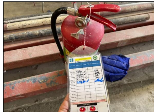
ภาพที่ 46 ตรวจสอบถังดับเพลิง
