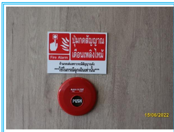
รูปที่ 3-34 ระบบสัญญาณเตือนภัยภายในโครงการ
