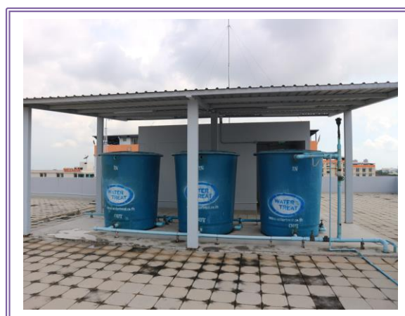
รูปที่ 2.5-1 ถังสำรองน้ำดาดฟ้า
