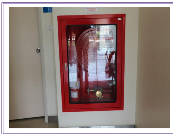
รูปที่ 2.7-1 ตู้เก็บสายฉีดน้ำดับเพลิง
