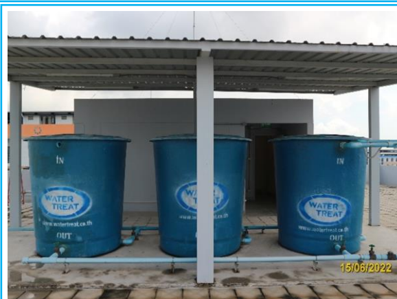
รูปที่ 3-21 ถังสำรองน้ำบนดาดฟ้าของโครงการ
