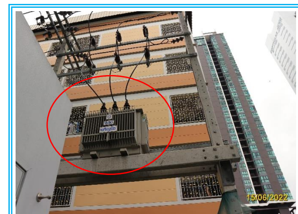
รูปที่ 3-24 หม้อแปลงไฟฟ้า
