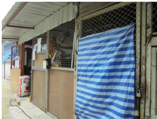
ภาพที่ 5-16 ห้องเก็บวัสดุอุปกรณ์และทำงานที่เกิดฝุ่นละอองแบบระบบปิดไม่ให้ฝุ่นฟุ้งกระจายออกสู่ภายนอก
