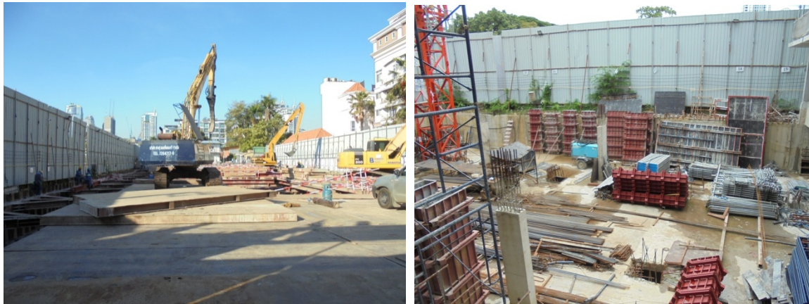
5-4 ทำระบบกันดินพัง Sheet Pile และปูพื้นด้วยเหล็กหนาเป็นทางวิ่งรถ ปัจจุบัน เป็นพื้นคอนกรีตทั้งหมด
