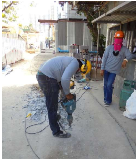
5-12 สวมใส่อุปกรณ์ป้องกันภัยส่วนบุคคล ที่ครบถ้วนในการทำงานที่มีเสียงดังค่อนข้างสูง
