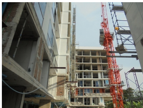
ภาพที่ 5-23 ติดตั้งเครนให้แขนเครนอยู่ภายในโครงการ
