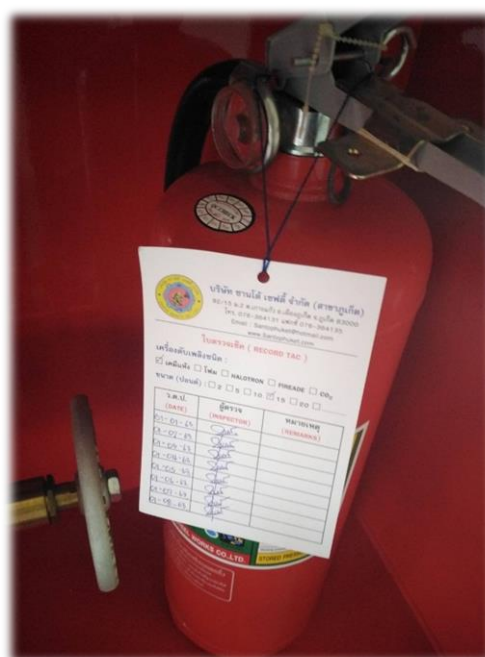
ภาพที่ 2-25 ตรวจเช็คถังดับเพลิง
