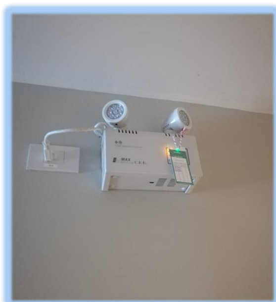
ภาพที่ 1-15 ไฟส่องสว่างฉุกเฉิน
