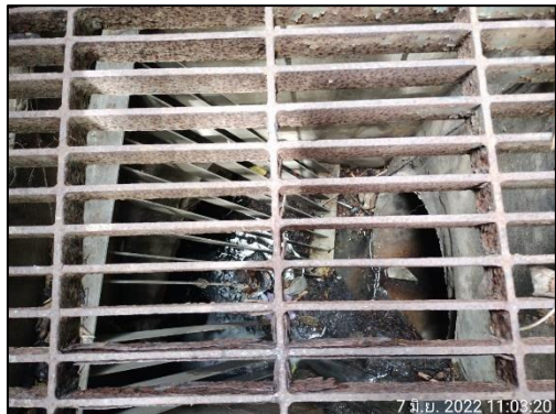
ภาพที่ 20 ตะแกรงดักขยะ
