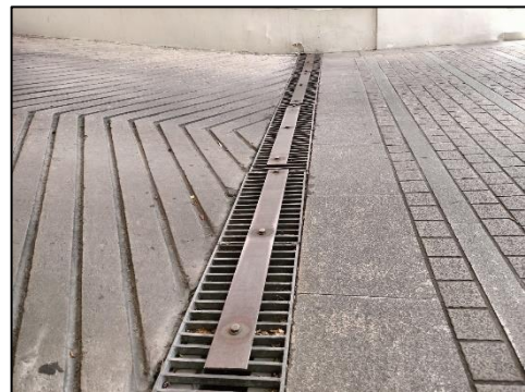
ภาพที่ 12 รางระบายน้ำภายในโครงการ
