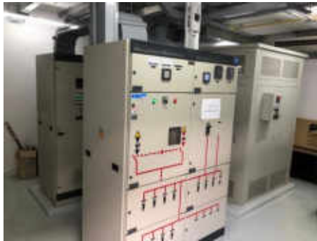
แผงจ่ายไฟฟ้าหลัก (Main Distribution Board; MDB)
