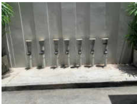
ระบบกำจัดก๊าซจากระบบบำบัดน้ำเสีย
