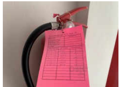
ถังดับเพลิงแบบมือถือ และการตรวจสอบ สภาพถังดับเพลิง
