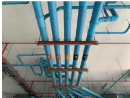
ท่อระบายน้ำเสีย (W) และท่อระบายของเสีย (S)
