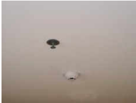
Smoke Detector และ Sprinkle
