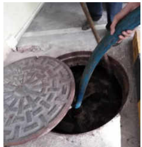
การสูบลากตะกอนจากระบบบำบัดน้ำเสีย
