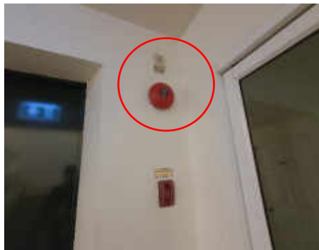
อุปกรณ์แจ้งเหตุเพลิงไหม้ด้วยมือ (Manual Station) และอุปกรณ์ส่งสัญญาณแบบกระดิ่ง (Alarm Bell)
